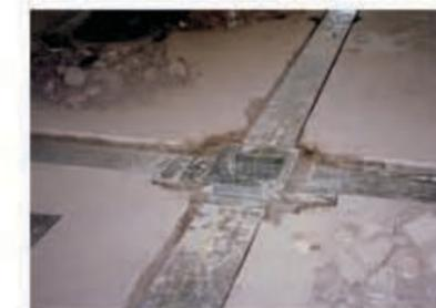
e) Contrapiso existente con canaletado para sistema bajo piso EQU.
