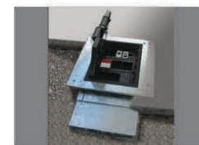
c) Vista de piso con carpeta sin terminar con conducto bajo piso -EQU-, caja bajo piso -UGE- (con regulación de altura) y caja portamecanismos GES6 3 cubetas.
