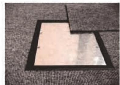
h) Vista de marco y tapa ZES6 sin revestir aún, instalado en caja bajo pavimento UGE 250/6
