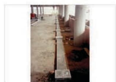
f) Obra nueva con tendido de conductos bajo piso y cajas bajo piso para futuros puestos de trabajo.
