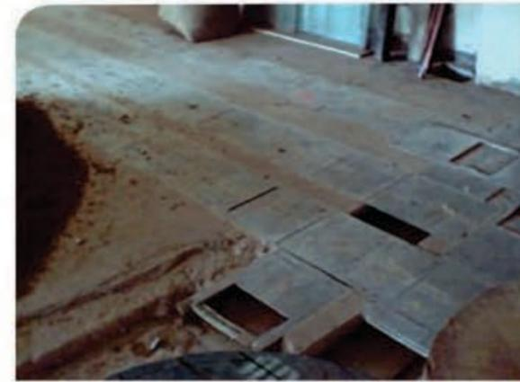
g] Instalación canal OQA -QDG6- en contrapiso listo para ser terminado y cubierto con alfombra, y recibir cajas portamecanismos QES6 o GQC6 para alimentar los puestos de tarabajo.
