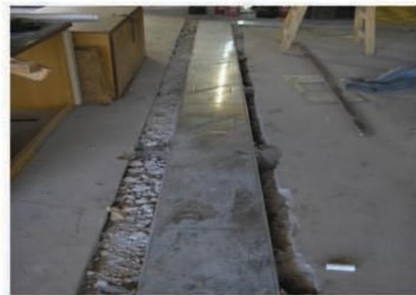
d] Instalación de canal OQA antes de completar relleno en contrapiso.
