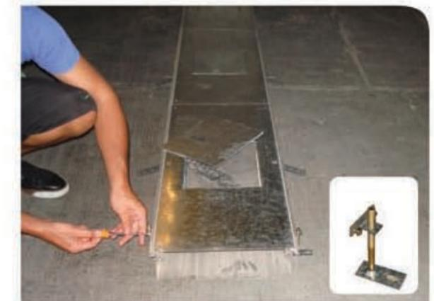
h] Tramo canal OQA con accesorios, regulando altura de bandeja antes de ser instalado.
