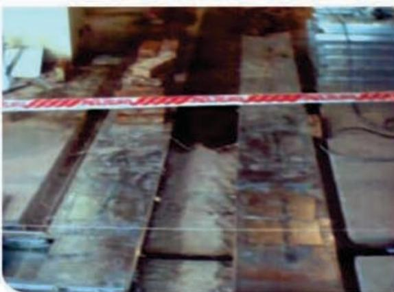
e] Canaleteado en contrapiso existente para montaje de canal OQA combinado con cañerías y cajas bajo pavimento DES.
