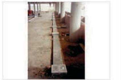
f) Obra nueva con tendido de conductos bajo piso y cajas bajo piso para futuros puestos de trabajo.
