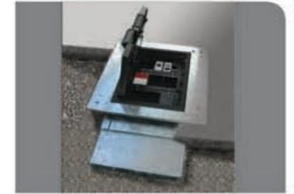
c) Vista de piso con carpeta sin terminar con conducto bajo piso -EQU-, caja bajo piso -UGE- (con regulación de altura) y caja portamecanismos GES6 3 cubetas.
