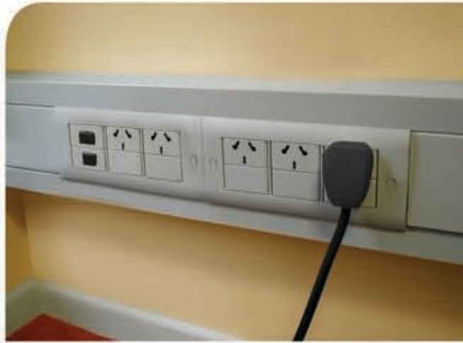
a) Canal metálico 65x133 con puesto de trabajo tipo, montado a la altura de zócalo..
